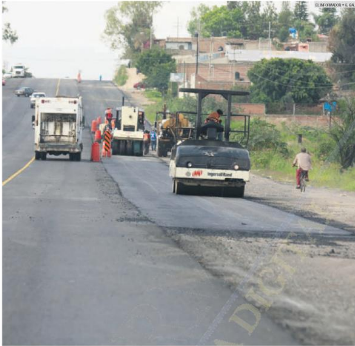
NUEVE KILÓMETROS PENDIENTES. Salvador Fernández, director del Centro Jalisco de la SCT, dijo que la construcción no será deficiente.
