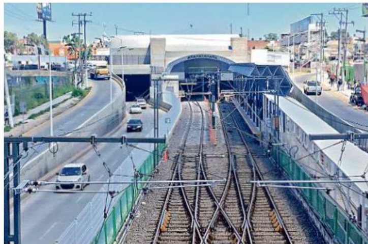
La obra de ampliación de la estación Periférico Norte y la construcción de la de Auditorio lleva nueve meses de retraso, luego del incumplimiento de la empresa que la realizaba.
