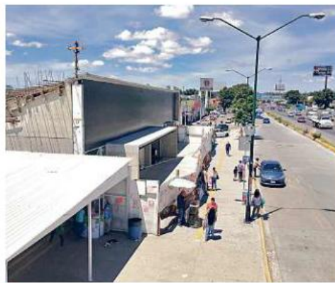
En la estación Periférico Norte aún no se coloca la vegetación que adornará el ingreso; comerciantes denuncian pérdidas.
