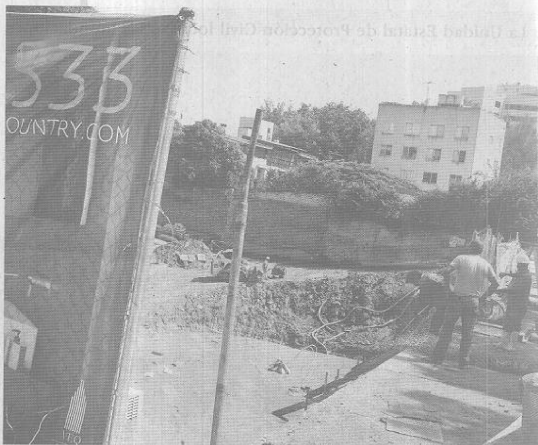
• El desarrollo "Q-Country" se construye en la calle Mar Caspio número 2110, en la colonia Country Club de Guadalajara.
