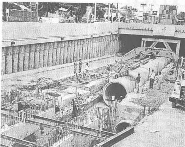
> Al terminar la colocación del colector en el túnel de Las Rosas comenzará el encofrado, pavimentación y las rampas.
