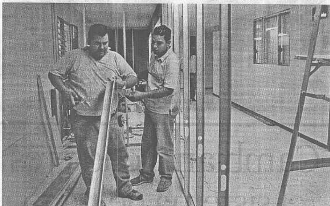
La ampliación de las oficinas de la Dirección Jurídica y de informática deberá quedar lista en un mes.
