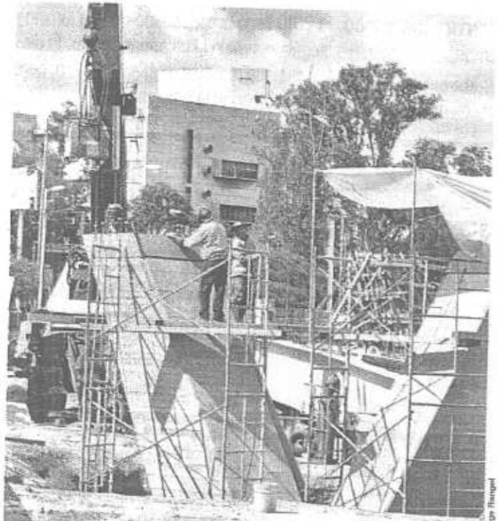
> La construcción del Puente Atirantado en Lázaro Cárdenas y López Mateos lleva un 40 por ciento de avance y ya se notan las estructuras que se edifican y soportarán la vía elevada.
