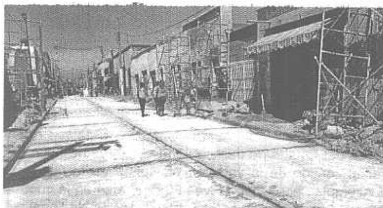
> La rehabilitación de calles y fachadas en el Centro de Zapopan concluirá después de la semana de Pascua.
